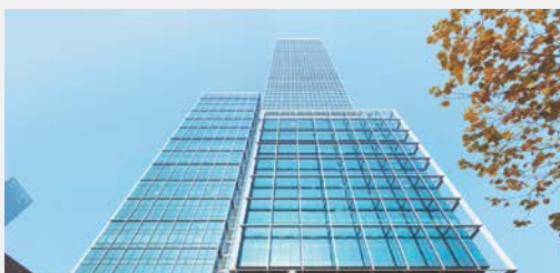
Многоэтажное здание без стилобата
